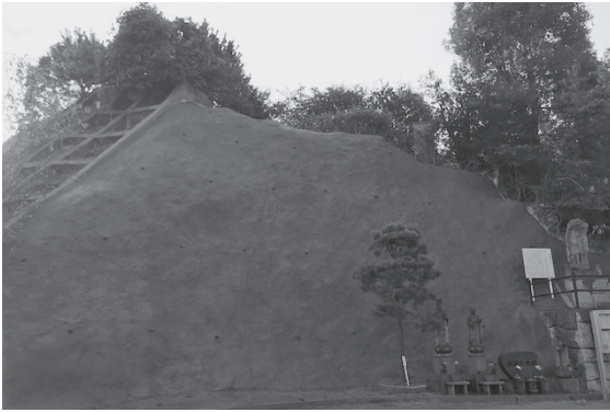
境内法面工事完成ご報告 [H30. 7 西日本土砂災害より]
